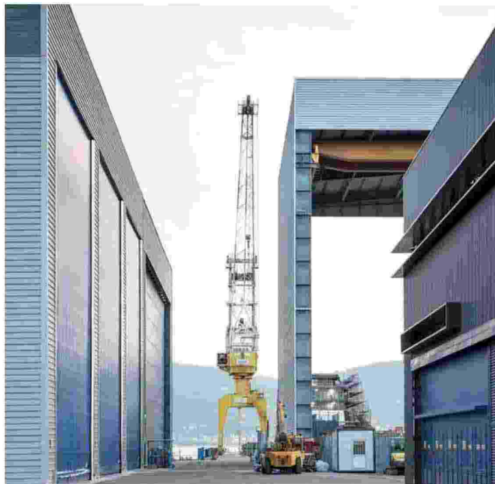
Il cantiere Sanlorenzo a La Spezia (FOTO SIMONE BOSSI)
