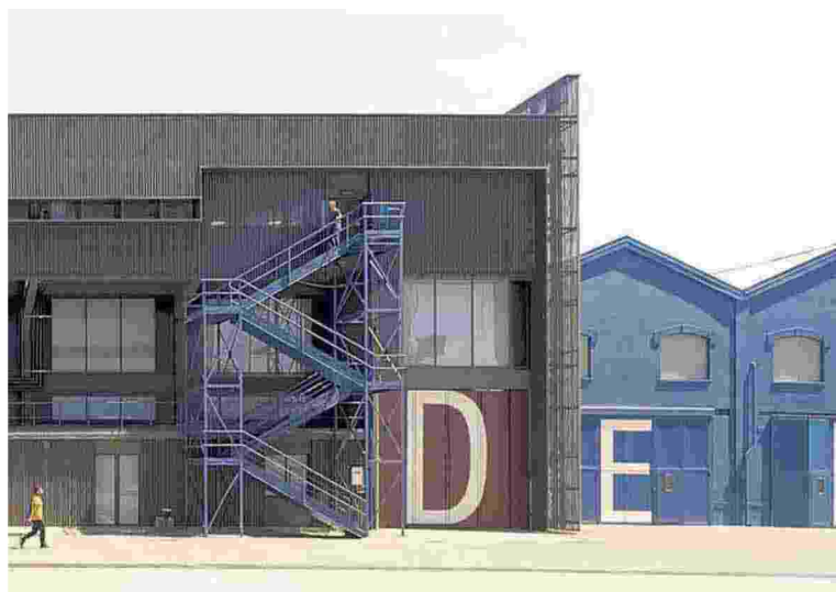
► Uno dei cantieri del gruppo Sanlorenzo
