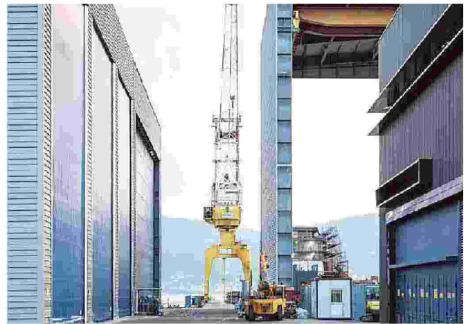
Il cantiere spezzino di Sanlorenzo
